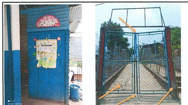
Foto 4: a) Sustitución de Puerta. B) Sustitución de Portón de Metal
