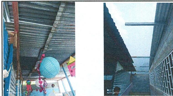
Foto 2: Sustitución de lámina, por lámina ondulada normal calibre 28
