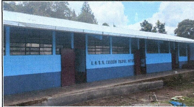
Foto 3: sustitución de canal de metal
