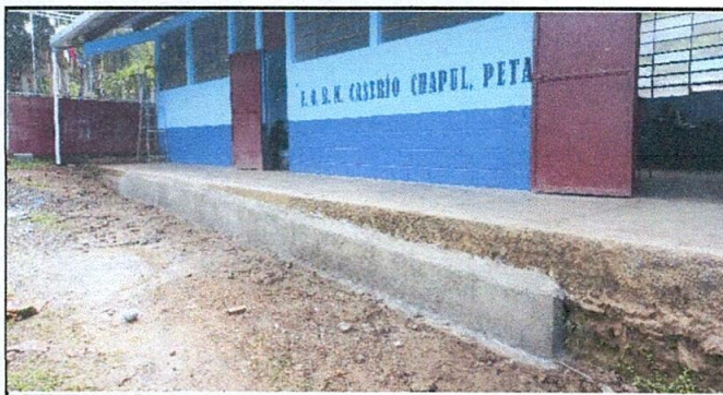
Foto 5: reparación de muro contención con block.
