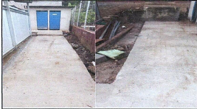
Foto 7: sustitución de piso de torta de concreto
