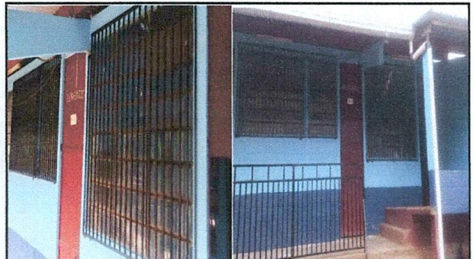
Foto 4: Sustitución de balcones de metal
