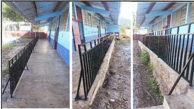
Foto 3: sustitución de baranda de madera, por baranda de metal
