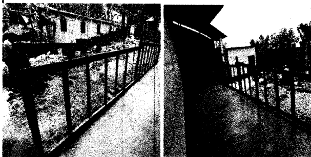
Foto 3: sustitución de baranda de madera, por baranda de metal
