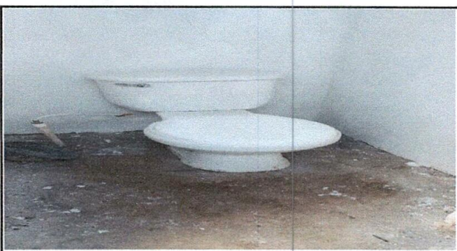
Foto 8: Sustitución de tazas por tazas de baño
