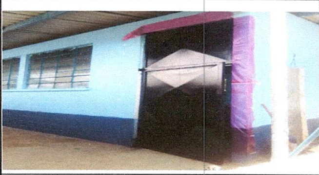
Foto 6: Sustitución de pintura de puertas
