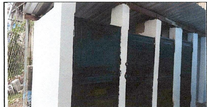
Foto 6: Reparación de baños
