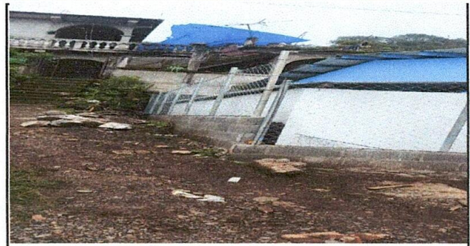
Foto 2: Sustitución de malla perimetral
