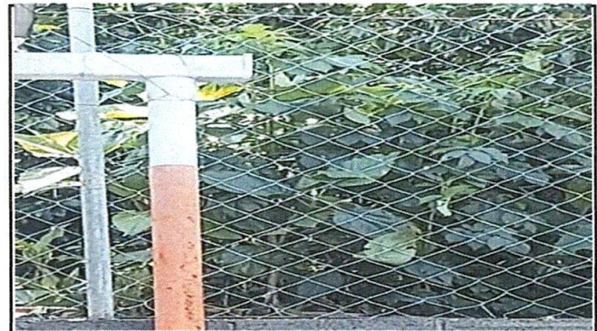
Foto 4: Sustitución de canaleta por canaleta
