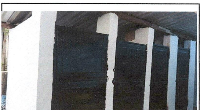
Foto 9: Sustitución de puerta de baños
