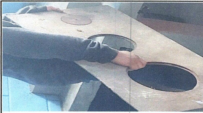
Foto 3: Sustitución de plancha por plancha
