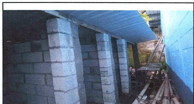
Foto 6: Reparación de baños
