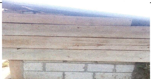
Foto 6: Reparación de baños
