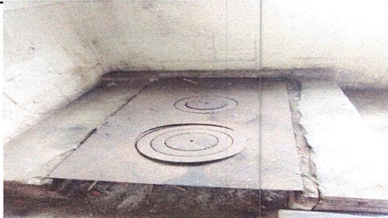
Foto 3: Sustitución de plancha por plancha
