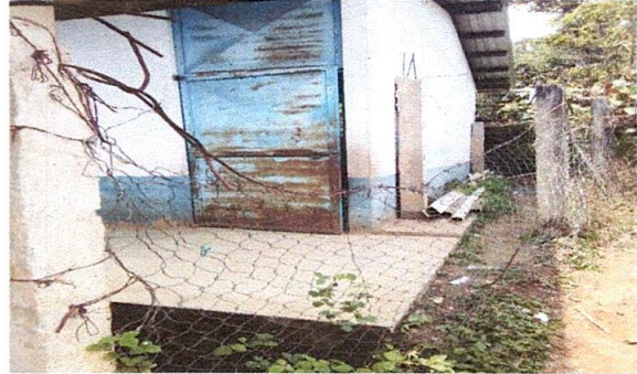
Foto 2: Sustitución de malla perimetral
