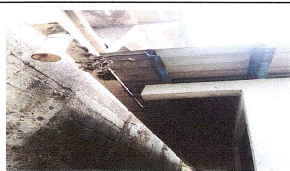
Foto 4: Sustitución de canaleta por canaleta
