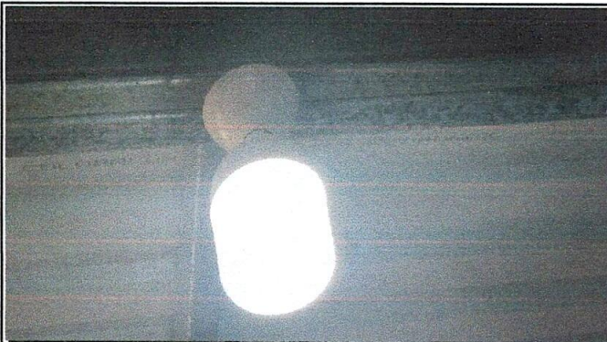
Foto 3: Sustitución de focos por foos ahorradores
