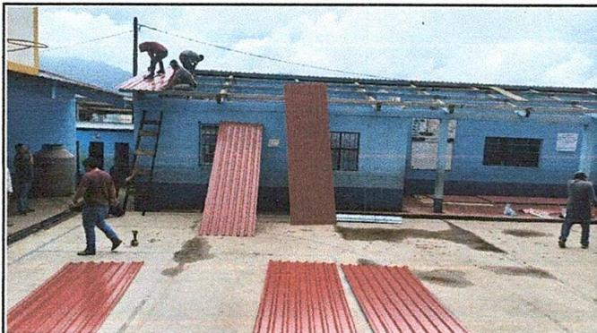
Foto 1: Sustitución de lámina por lámina
