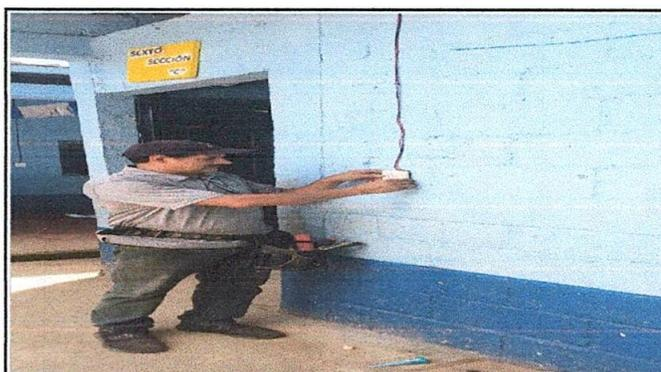
Foto 4: Sustitución de Tomacorrientes por tomacorrientes
