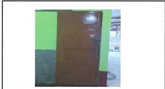
Foto 2: Puertas de baño de metal en buen estado.
