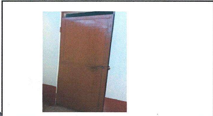
Foto 1: Puerta de baño de metal después del proceso.
