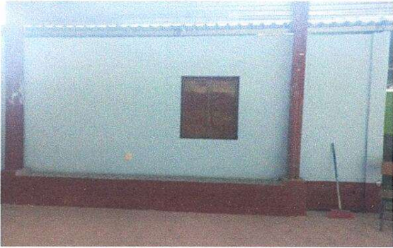
Foto 7. Pared de cocina reparada
