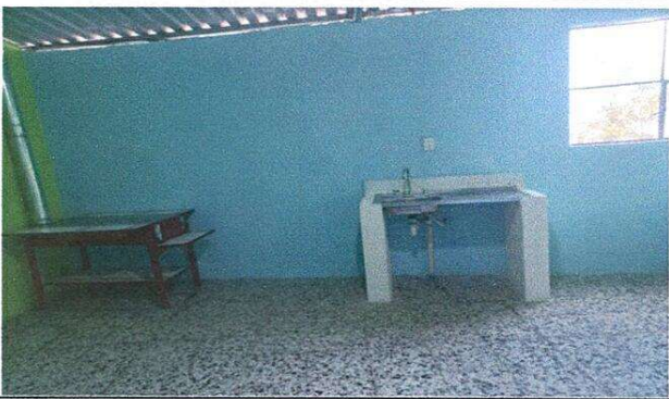
Foto 9. Cocina reparada finalizada
