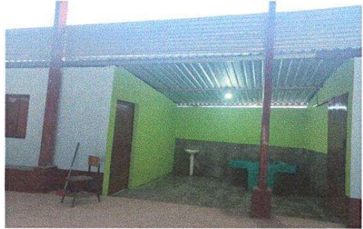
Foto 8. Techo de cocina sustituido en buen estado
