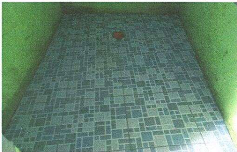
Foto 3: despues de colocar el piso se colocará la nueva tasa
