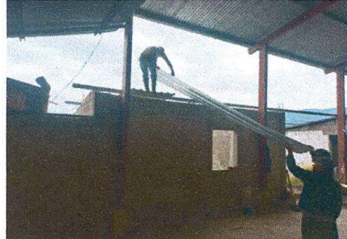
Foto 4: Iniciando a colocar el nuevo techo.
