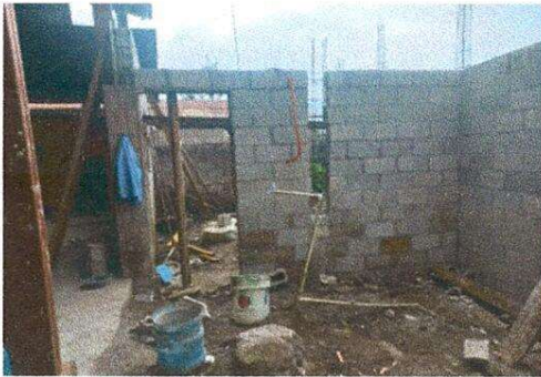
Foto 3: Pared ya sustituida.
