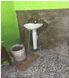
Foto 5: Cambio de lavamanos
