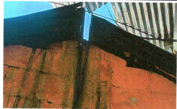
Foto 4: techo de lámina en mal estado
