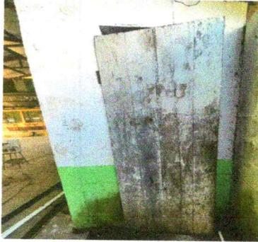
Foto 1: Puerta de baño deteriorada
