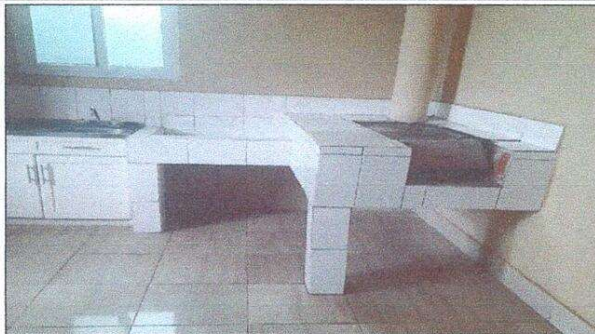
Foto 1: terminación de la plancha. Renglón: reparación de cocina
