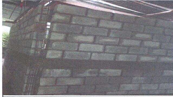
Foto 2: en proceso de función de columnas Renglón: reparación de cocina
