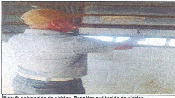
Foto 5: colocación de vidrios. Renglón: sustitución de vidrios
