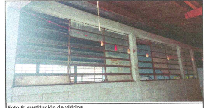
Foto 6: sustitución de vidrios
