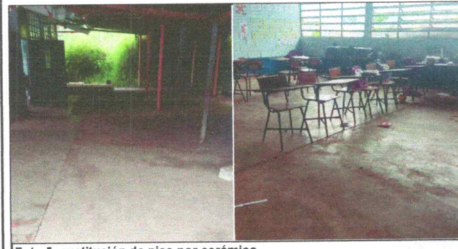
Foto 5: sustitución de piso por cerámico
