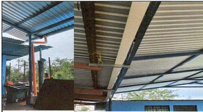
Foto 3: CANALES Y BAJADAS DE AGUA PLUVIAL
