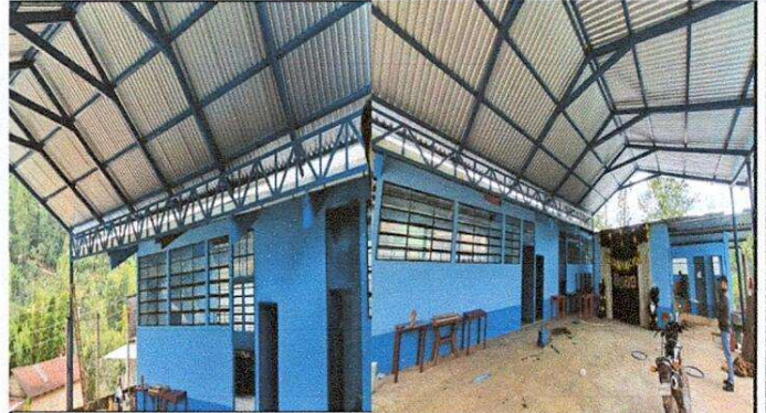
Foto 2: ESTRUCTURA DE TECHO
