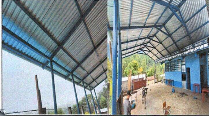
Foto 1: CUBIERTA DE LÁMINA
