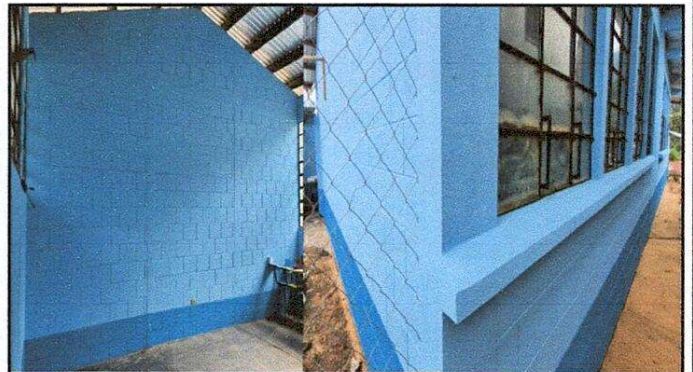
Foto 4: PINTURA EN MUROS EXTERIORES E INTERIORES
