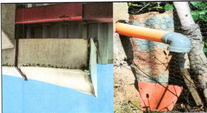
Foto 3: CANALES Y BAJADAS DE AGUA PLUVIAL
