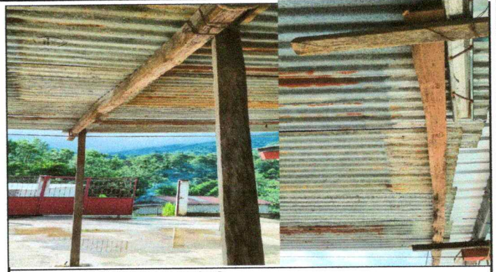
Foto 2: ESTRUCTURA DE TECHO
