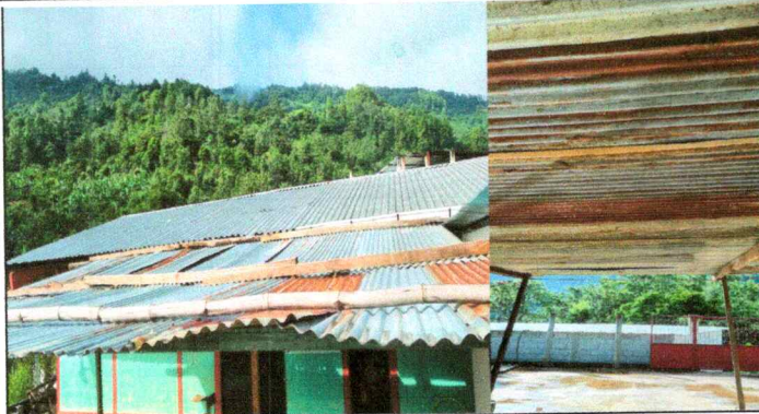
Foto1: CUBIERTA DE LÁMINA
