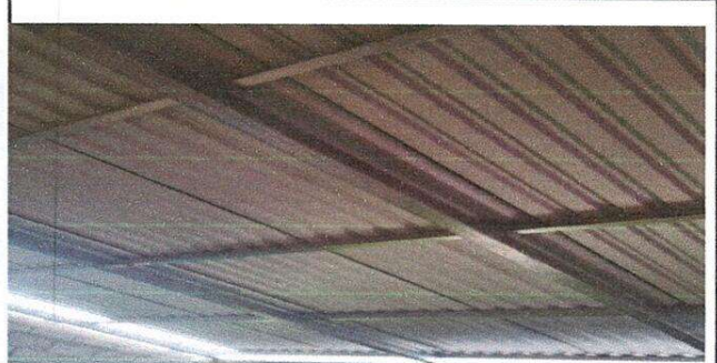
Foto 4: trabajo finalizado en la estructura del techo y lámina.
