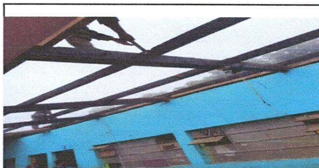
Foto 4: Desmontaje de techo en el corredor.
