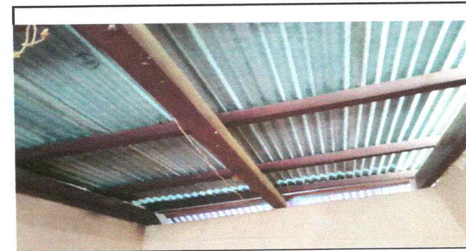
Foto 6: Sustitución de estructura de soporte.
