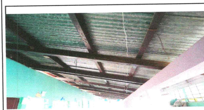
Foto 5: Sustitución de estructura.
