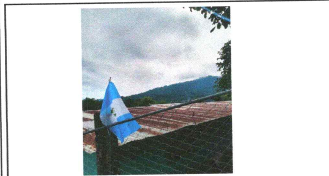
Foto 3: Sustitución de lámina.
