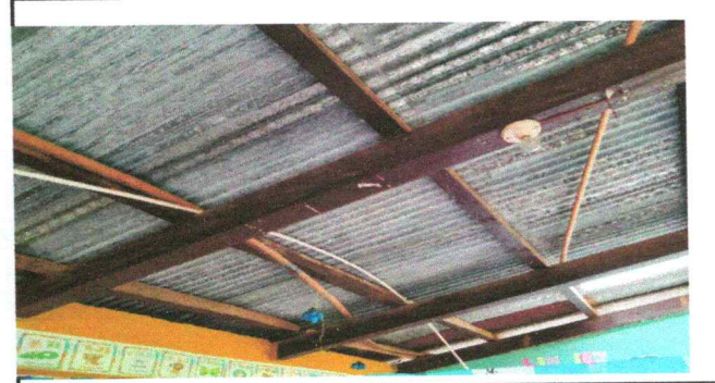
Foto 4: Sustitución de estructura
