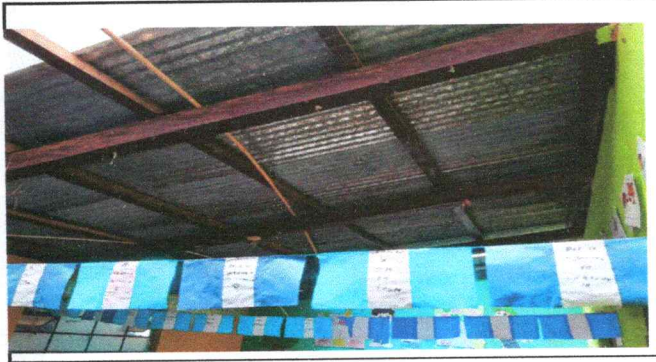
Foto 2: Sustitución de lámina
