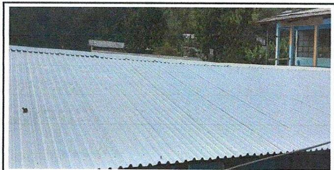
Foto 5: Sustitución de capotes en mal estado
