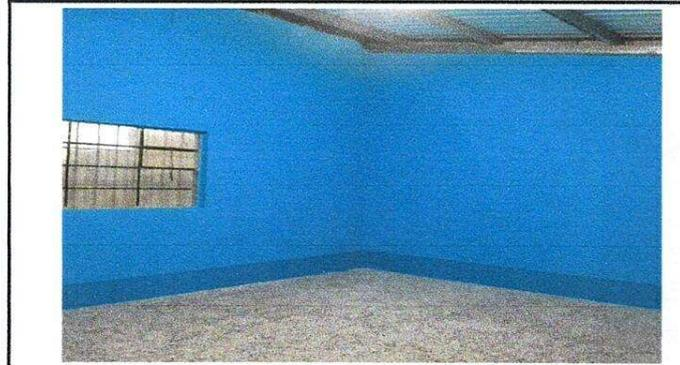
Foto1: Sustitución de piso de torta de cemento por cerámico de granito en aulas, cocina y dirección
