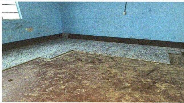
Foto1: Sustitución de piso de torta de cemento por cerámico en aulas, cocina y dirección
