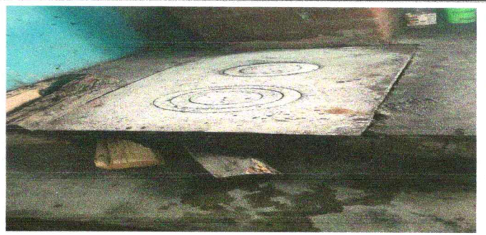
Sustitución de plancha vieja por plancha nueva y se arregla el piso con cerámico
