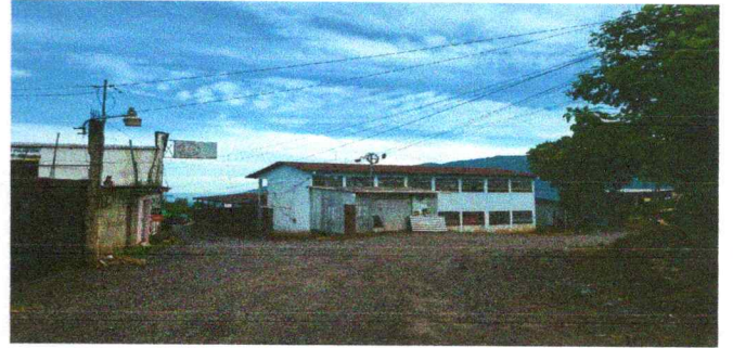
Sustitución de pintura en muro y paredes de la escuela.
