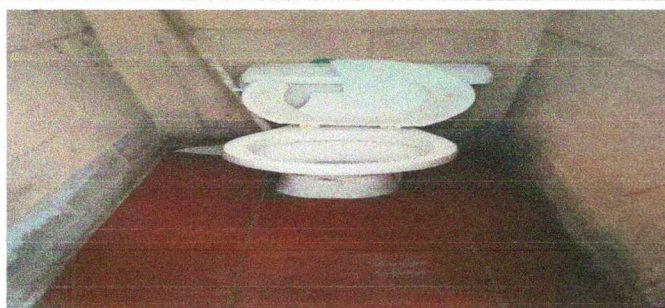
Sustitución de letrinas quebradas por letrinas nuevas.
