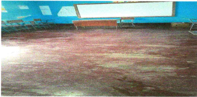
Sustitución de piso de torta de cemento, por cerámico de granito en el aulas, cocina y dirección.
