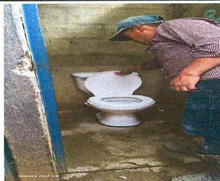
Foto 32: Vista de la colocacion de los sanitarios
