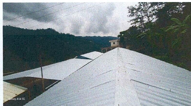
Foto 33. Vista del techo de las aulas del nivel primario
