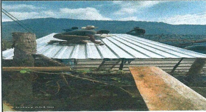
Foto 7: Colocacion de las láminas en el techo de las aulas del nivel primario
