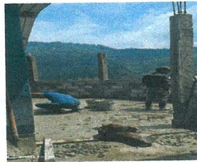
Foto 12. Trabajando el piso del centro educativo
