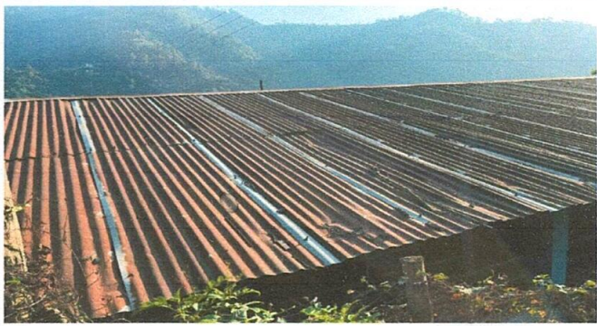
Foto 1: cambio de techo
