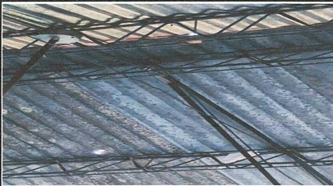
Foto 3: Cambio de techo del salón escolar
