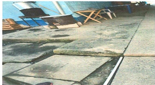
Foto 6: Reparación de piso de torta de concreto
