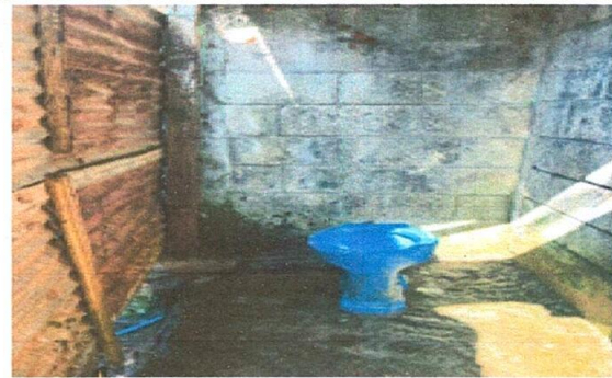
Foto 4: Sustitución de inodoro
