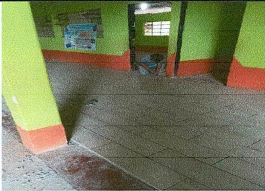
Foto 3: Sustitución de piso de torta por cerámico
