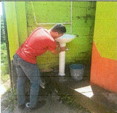
Foto 5: Sustitución de Lavamanos
