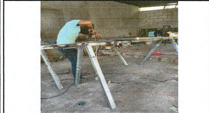
Foto1: Fabricación e instalación de balcones en ventanas
