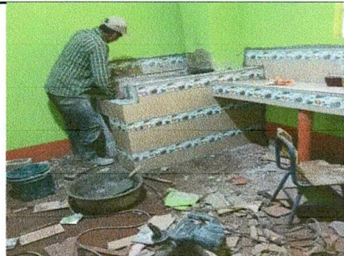
Foto 6: Sustitución de estufa rural de leña e instalación de azulejo
