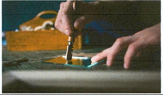
Foto 2: cortando vidrios para las ventanas
