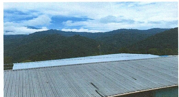
Foto 6: Susutitución de lamina por lamina troquelada.
