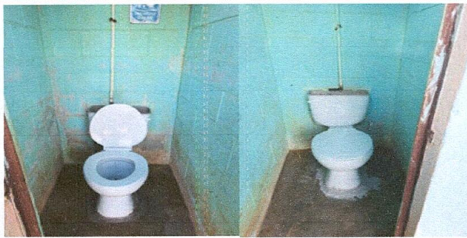
Foto 3: Sustitución dde inodoro
