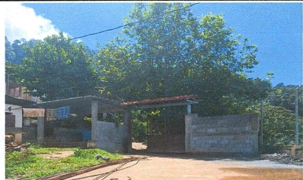
Foto 4: Reparación de muro perimetral
