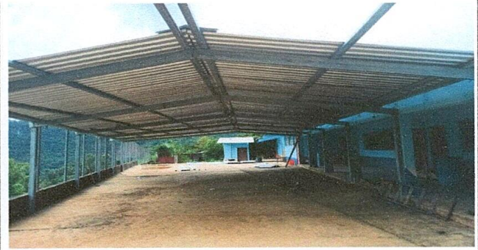
Foto 2: Sustitución de soporte de madera por soporte de metal
