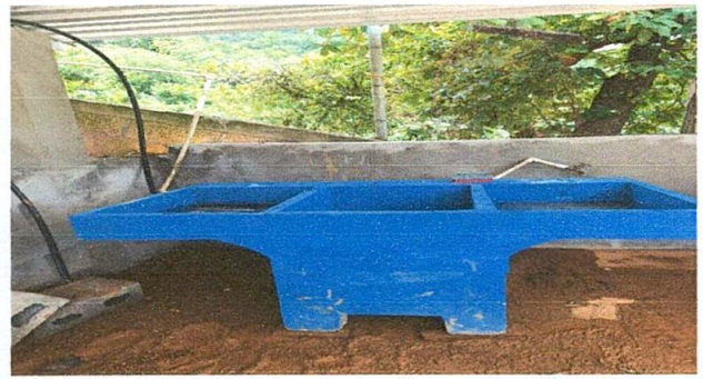
Foto 4: Sustitución de pila de cemento
