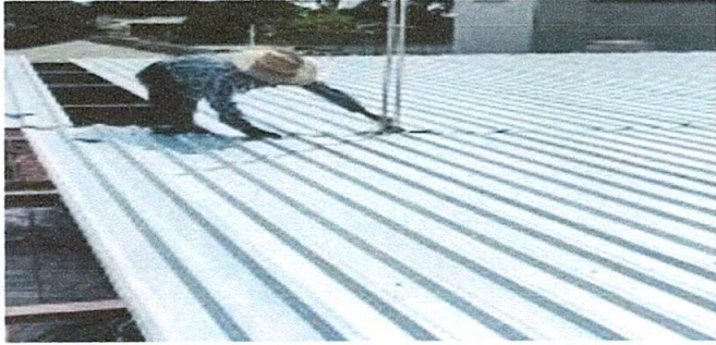
Foto1: Susutitución de lamina por lamina troquelada.
