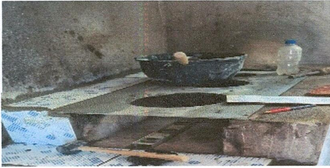
Foto1: Susstitución de plancha.
