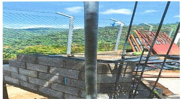
Foto 4: Reparación de muro perimetral
