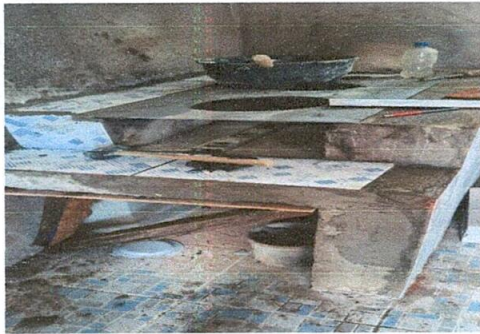
Foto 5: Instalación de azulejo en estufa rural
