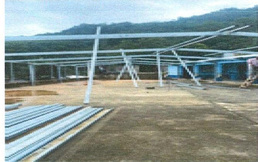
Foto 6: Susutitución de lamina por lamina troquelada.
