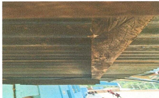
Foto 2. Sustitución de soporte de madera por soporte de metal.
