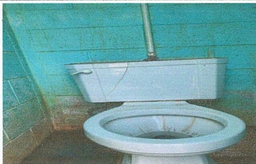
Foto 3. Sustitución de inodoros.
