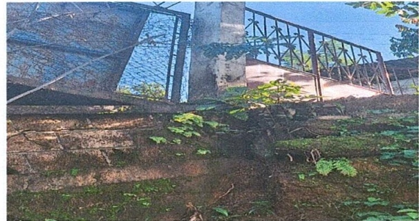
Foto 4: reparación de muro perimetral
