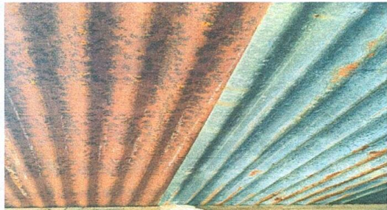
Foto 1. Sustitución de lámina por lámina troquelada.
