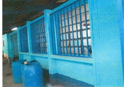
Foto 2: Instalación finalizada de balcones de metal
