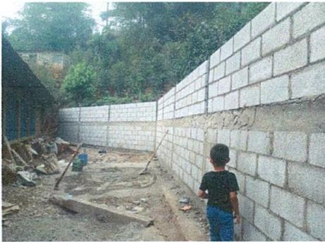
Foto 3: Finalización del trabajo de muro de contencion
