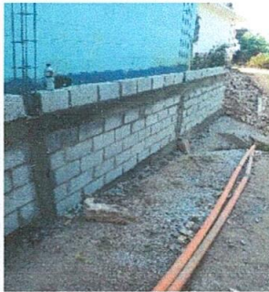
Foto 3: Trabajando en el muro de contencion
