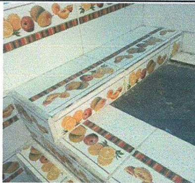
Foto 9: Instalación de azulejo finalizada en el área de estufa rural.
