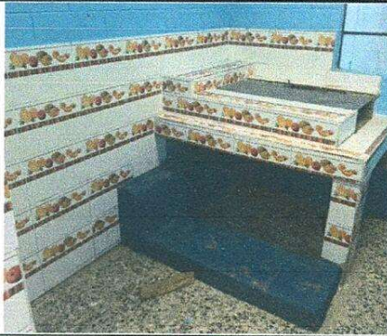
Foto 7: Sustrucción de la plancha de metal de tres hornillas y colocación de azulejo finalizada en el área de estufa rural.
