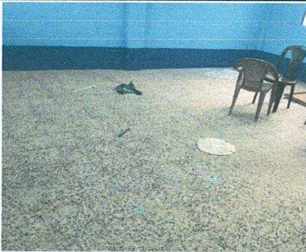
Foto1: Colocación de piso de granito finalizada en interior de aula
