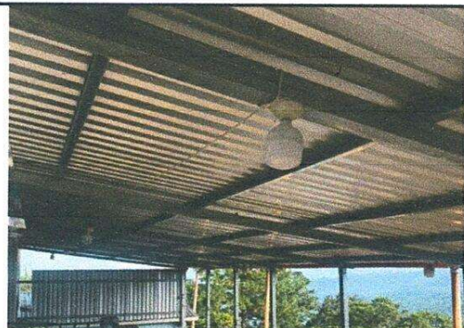
Foto 10: Sustrucción finalizada de focos o bombillos ahorradores en techo del patio.
