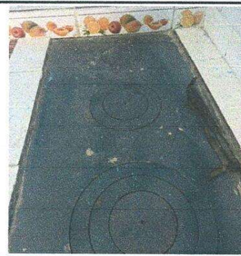
Foto 8: Sustrucción finalizada de la plancha de metal de tres hornillas.
