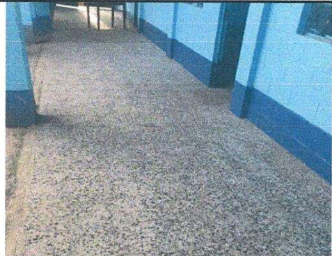
Foto 2: Colocación del piso de granito finalizada en el área del corredor.
