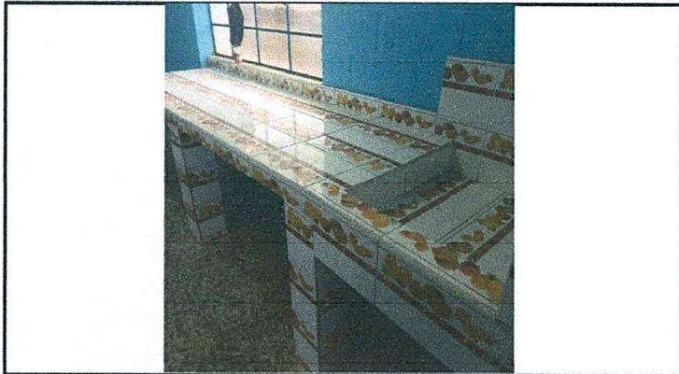
Foto 13: Mueble de cocina terminado.
