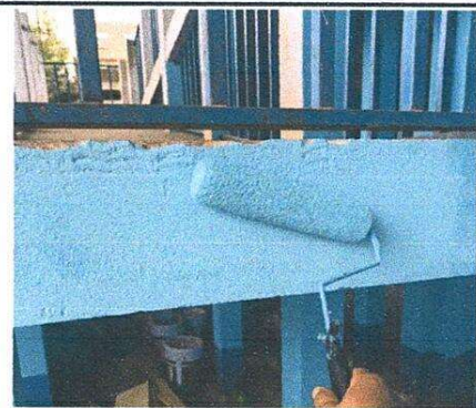
Foto 4: Aplicación de pintura en el área de rampa de acceso al segundo nivel.
