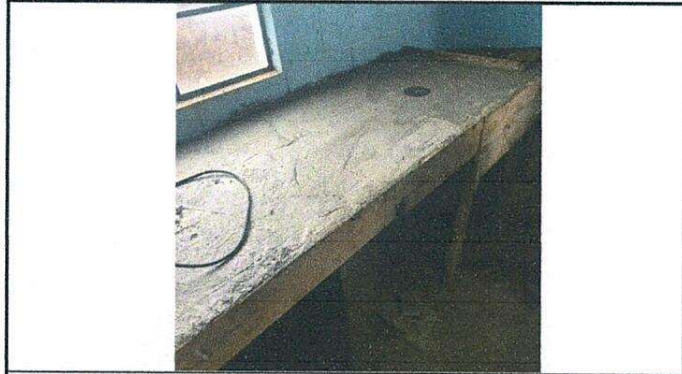
Foto 13: Mejoramiento de mueble de cocina.
