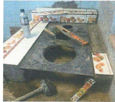
Foto 8: Sustitución de la plancha de metal de tres hornillas.
