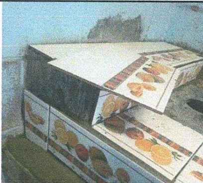
Foto 9: Instalación de azulejo en el área de la estufa rural.
