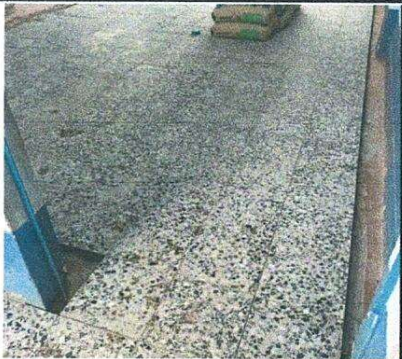
Foto 3: Instalación del piso de granito en el interior del aula.
