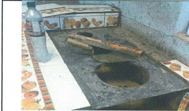
Foto 7: Sustitución de la plancha de metal de tres hornillas y colocación de azulejo en el área de la misma.
