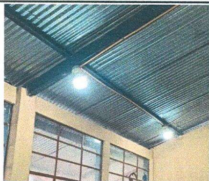
Foto 11: Colocación de bombillos led.
