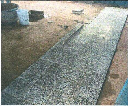
Foto 1: Se está colocando el piso de granito en el interior de una de las aulas.
