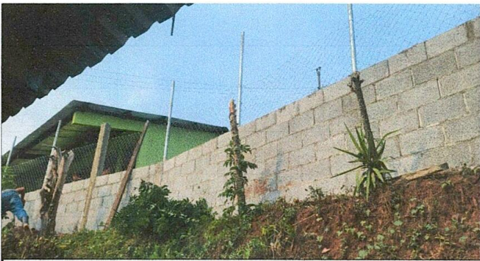
Foto 6: reparación de muro perimetral de block con tubo hg y malla galvanizada, soleras intermedias y columnas
