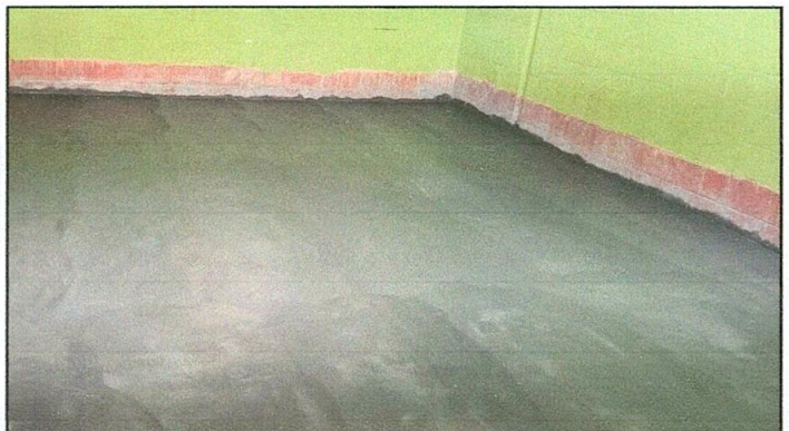
Foto 4: reparación de piso de torta de concreto
