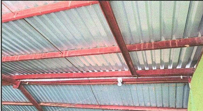
Foto 1: sustitución de lámina por lámina troquelada
