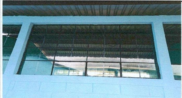
Foto 3: Trabajando finalizado en la sustitución de vidrios
