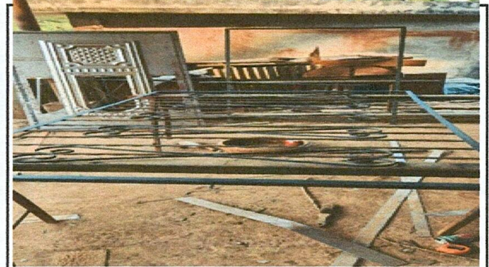
Foto 4: Trabajando los balcones
