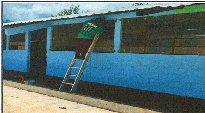
Foto 2: Avance en el trabajo de pintura.
