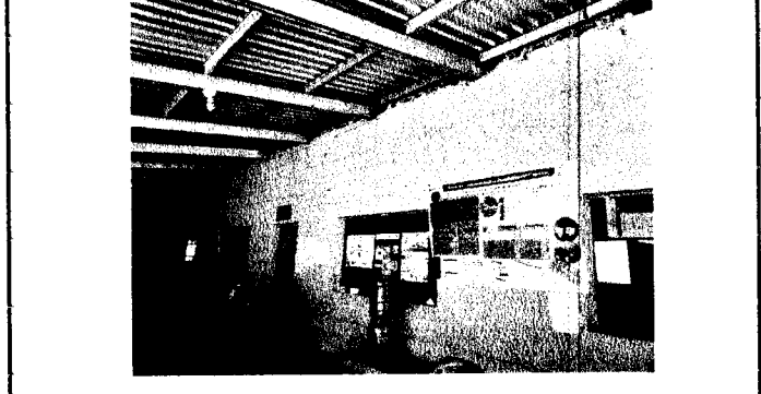
Foto 4: Reparación de repello y cernido de paredes. Matenimiento de paredes en aulas.
