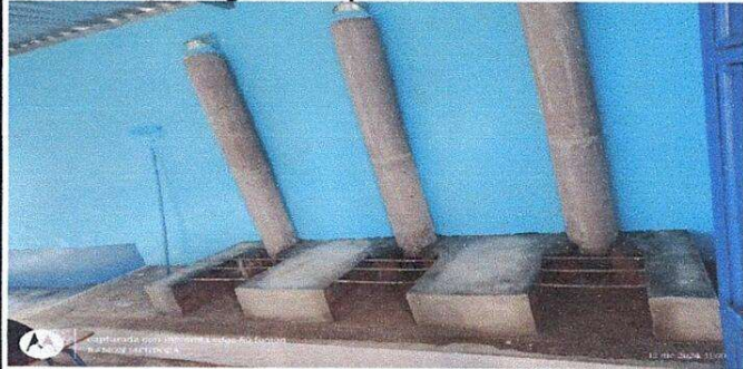
Foto 2: los fogones completados al 100%
