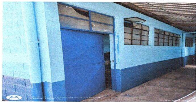
Foto 15: se finaliza con la pintura en los muros de la escuela
