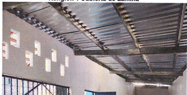
Foto 4: Así quedó la cubierta de lámina
