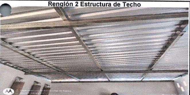
Foto 5: Se inicia el trabajo con el cambio de la estructura del techo
