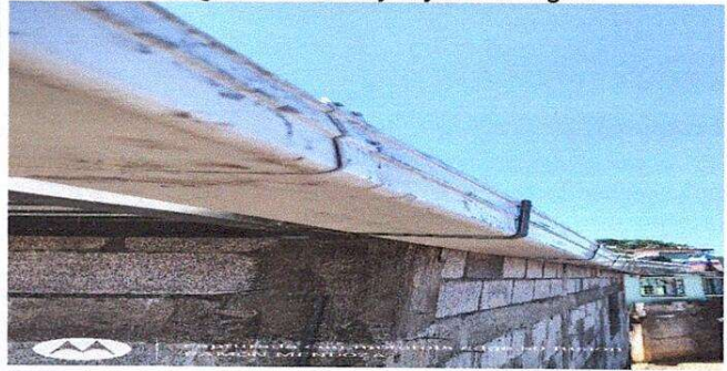
Foto 14: De esta forma quedaron instaladas los canales
