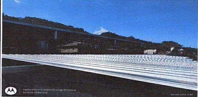
Foto 4: se puede apreciar el avance de la cubierta de lámina ya casi finalizando el renglón
