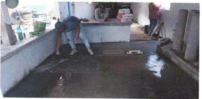
Foto 11: Se inicia el trabajo en el piso
