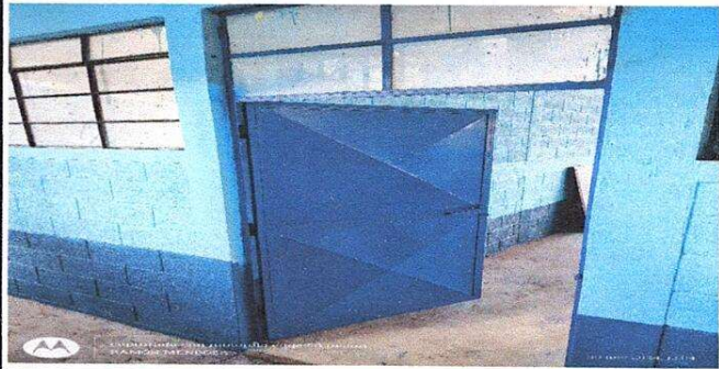
Foto 8: Se le dio un acabado de pintura a las puertas
