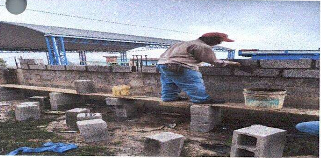
Foto 17: Los Muros perimetrales se encuentran incompletos.
