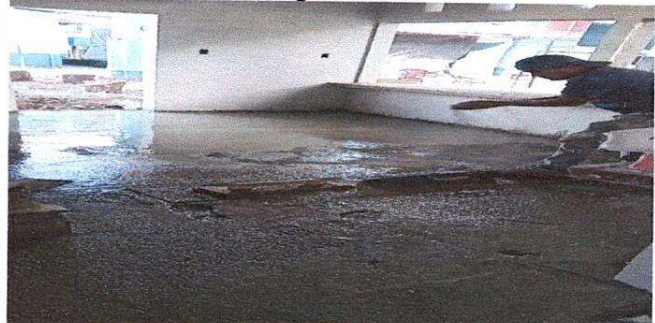
Foto 12: se puede observar el trabajo en la mejora del piso con torta de cemento
