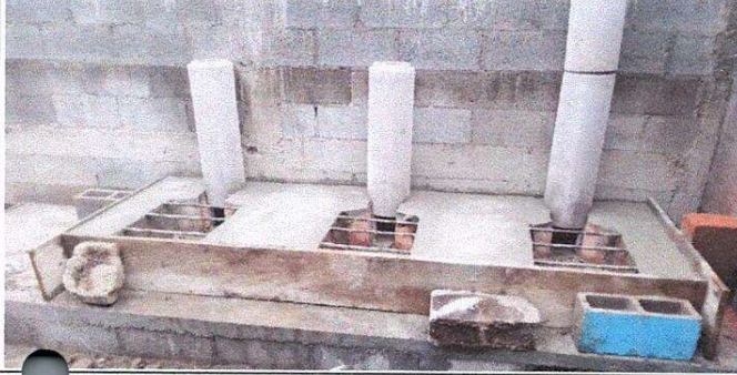
Foto 1: Se puede apreciar el avance de los fogones de la cocina
