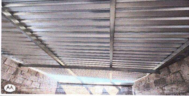
Foto 3: Cubierta de lámina ya con un avance del 90%
