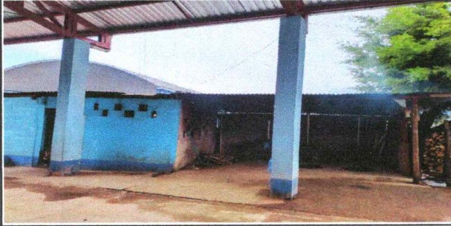
Foto 1: Vista frontal de la cocina y su ampliación incompleta
