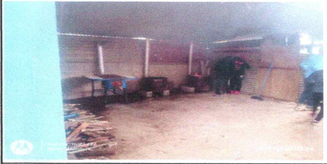
Foto 2: vista de la ampliación de la cocina incompleta
