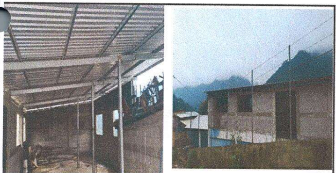
Foto 5: SUSTITUCION DE PARED DE LAMINA POR PARED DE BLOCK
