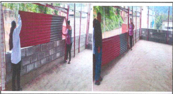
Foto 5: SUSTITUCION DE PARED DE LAMINA POR PARED DE BLOCK
