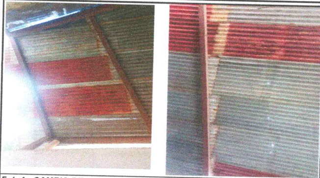
Foto 1: CAMBIO DE TECHO LAMINA POR LAMINA Y COSTANERA POR COSTANERA
