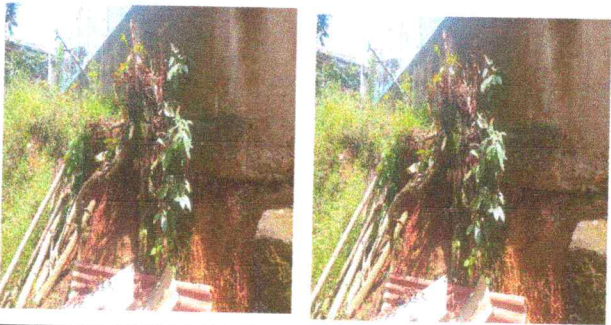
Foto 5: CONSTRUCCION DE MURO PERIMETRAL
