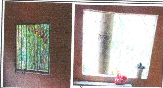
Foto 2: CAMBIO DE DOS VENTANAS EN LA COCINA DEL ESTABLECIMIENTO
