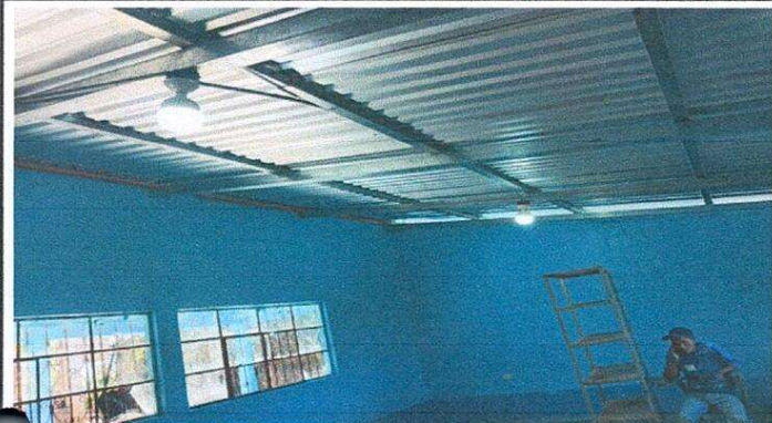
Foto 1: Estructura del Centro Educativo, en la parte de adentro del Establecimiento, con el proyecto finalizado.
