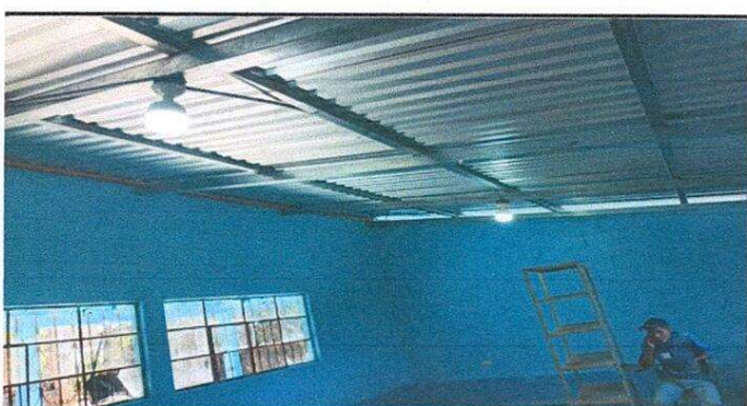
Foto 6: asi quedo la estructuras del Centro Educativo en la parte de adentro.
