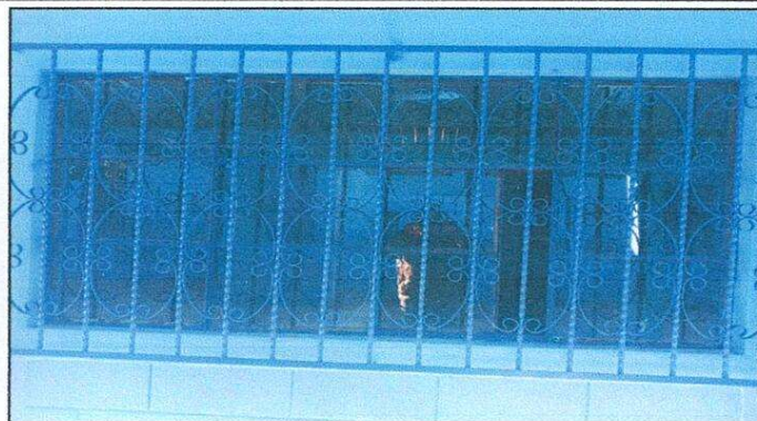
Foto 2: Balcones ya con su mantenimiento.
