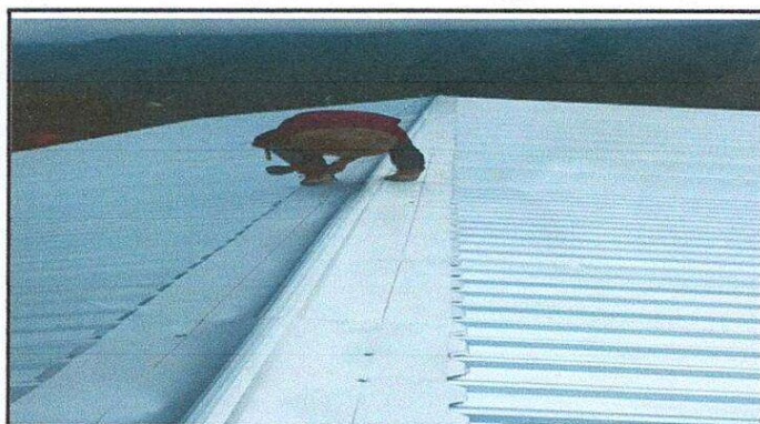
Foto 4: Centro Educativo con el techo ya finalizado.
