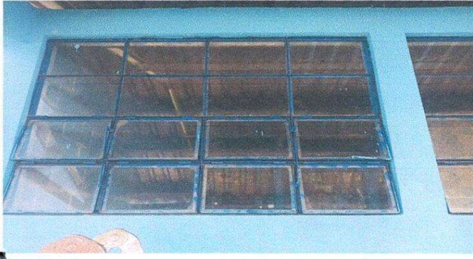
Foto1: Las ventanas del Centro Educativo ya Con Los vidrios Instalados
