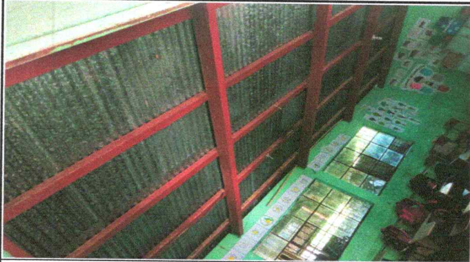
Foto1: estructura del centro educativo en la parte de adentro del Establecimiento.
