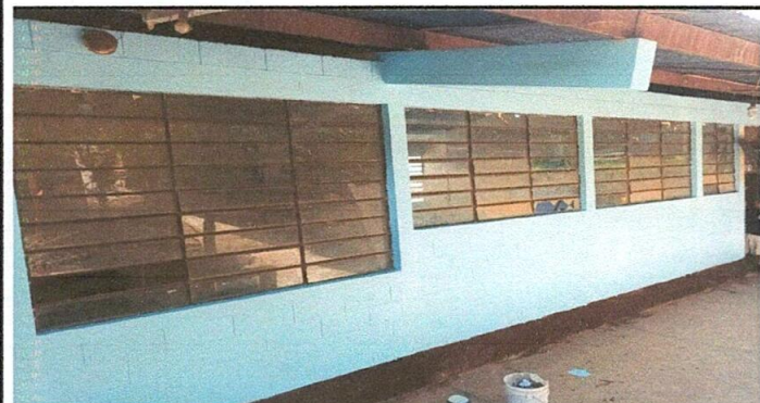
FOTO 5. SUSTITUCIÓN DE PINTURA
