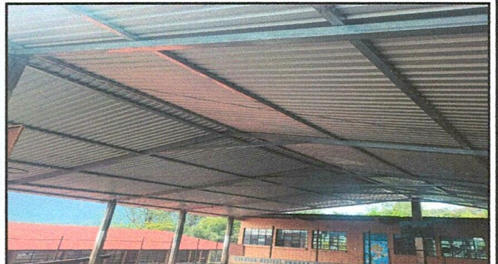
FOTO 2. CAMBIO DE TECHO DE CANCHA/ SALON
