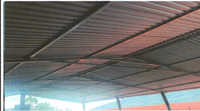
FOTO 3. REPARACION DE TECHO
