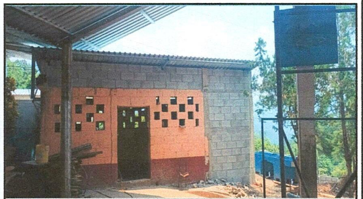
FOTO 4. REPARACION DE COCINA
