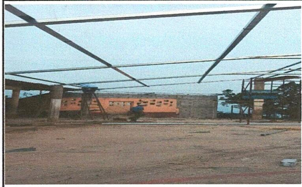
FOTO 2. CAMBIO DE TECHO DE CANCHA/ SALON
