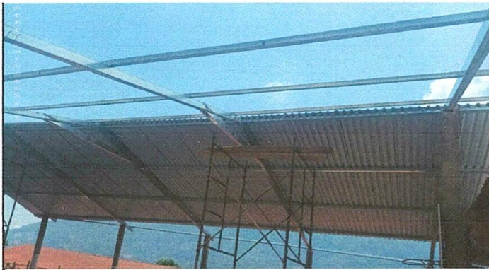
FOTO 3. REPARACION DE TECHO
