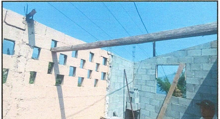
FOTO 4. REPARACION DE COCINA
