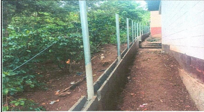
FOTO 1. REPARACIÓN DE CIRCULACION PERIMETRAL
