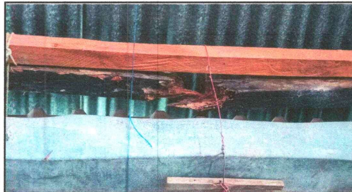
FOTO 3. REPARACION DE TECHO
