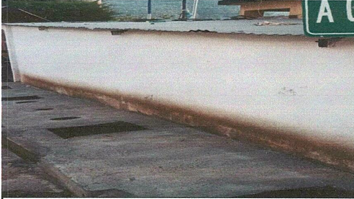
Foto 1. Repello de muro, fachada de la escuela
