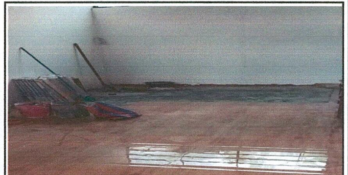
Foto 6. Repello y piso de la dirección
